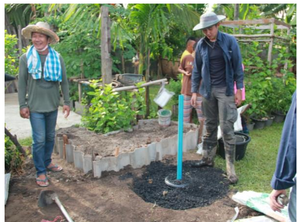
ภาพภาคผนวกที่ 3 การทำหลุมธนาคารน้ำใต้ดินแบบปิดในครัวเรือน
