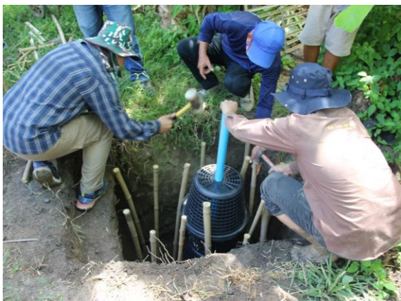
ภาพภาคผนวกที่ 3 การทำหลุมธนาคารน้ำใต้ดินแบบปิดในครัวเรือน
